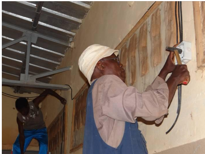
Bis in den Abend verlegen Simplicie Chaklizo und Ousséni Dicko Kabel an der Schule Namssiguias
