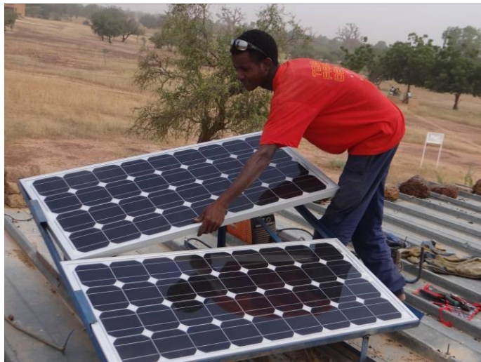
Zwei Solarpaneele werden auf dem Dach der Krankenstation montiert
