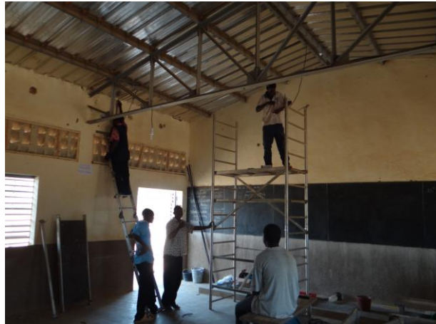
Die Techniker verkabeln den Klassenraum und installieren Energiesparlampen
