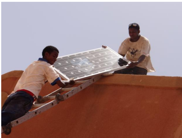
Das Solarpaneel wird auf das Dach gebracht
