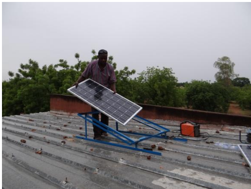
Techniker der Firma MicroSow bei der Montage des Solarpanels
