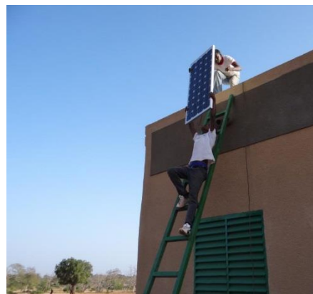
Der Transport der Photovoltaikmodule auf das Schuldach
